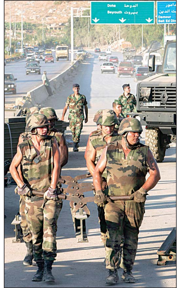
Soldanan di e dos Regimento Frances, ta carga parti di un brug temporario mientras nan ta trahando riba construccion pa replasa un brug riba e caminda principal den e ciudad Damour.
